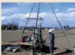
ボーリング調査
